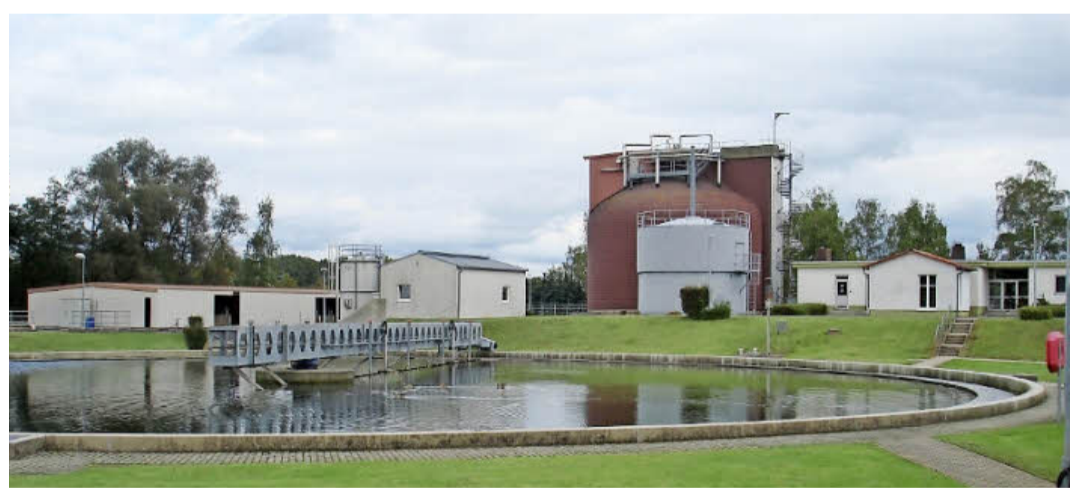
Die Kläranlage Küps arbeitet effizient und erwirkt Kosteneinsparungen.
